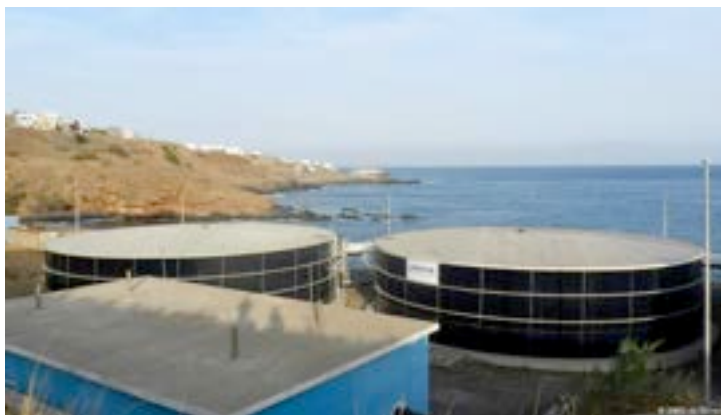
Estação de dessalinização em Cabo Verde. Fonte: DW / V. Teixeira.
