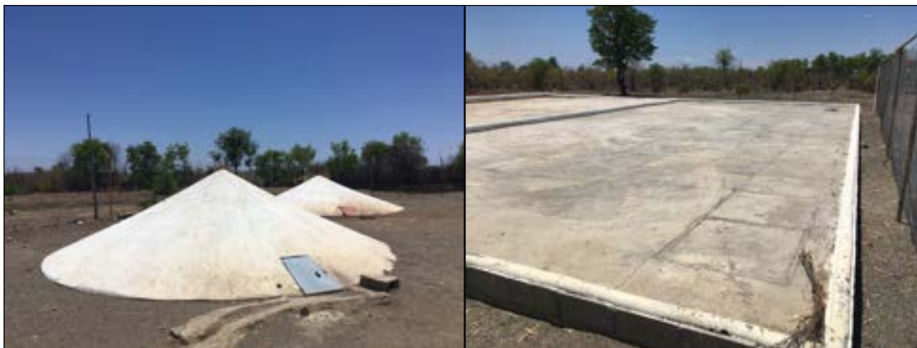
Componentes da cisterna-calçadão, Tunda Um (Chiange).
